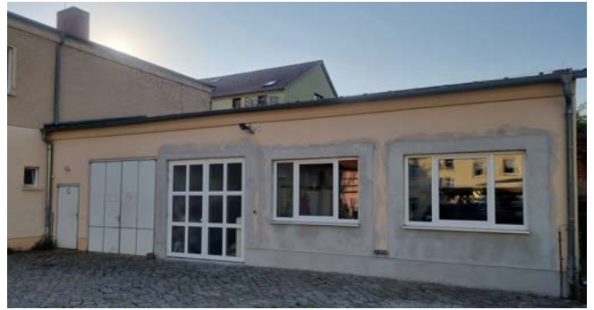
Hofansicht der Kleiderkammer Angermünde mit neuen Fenstern und neuer Tür ... nun fehlt nur noch der Anstrich
